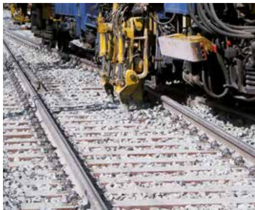
Am 9. September erfolgte das Stopfen der Weichen und abschließend wurden die Schienen verschweißt.
