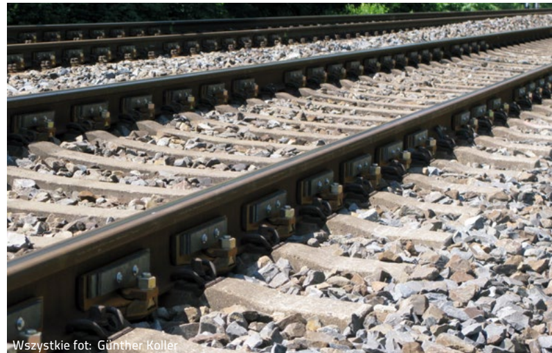
Rys. 1: Przykład systemu masowo-sprężynowego w funkcji tłumików szynowych
