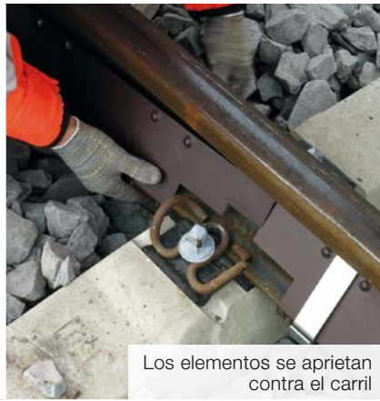
Instalación de los clips de sujeción
