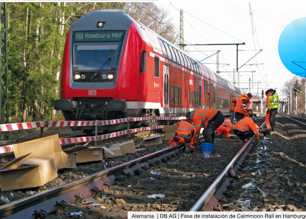
Instalación de Calmmoon Rail con corte de vía por la noche
