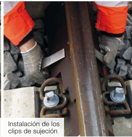
Los elementos se aprietan contra el carril
