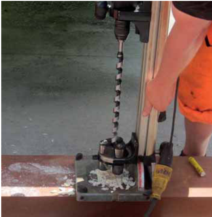
Erzeugung von Bohrlöchern in der Kustholzschwelle
