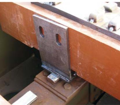
Supporto speciale per il legno sintetico FFU su struttura portante aperta in acciaio
