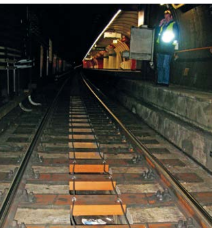
Lignes Viennoises | Traverse en bois artificiel FFU dans un tunnel sur semelle en caoutchouc
