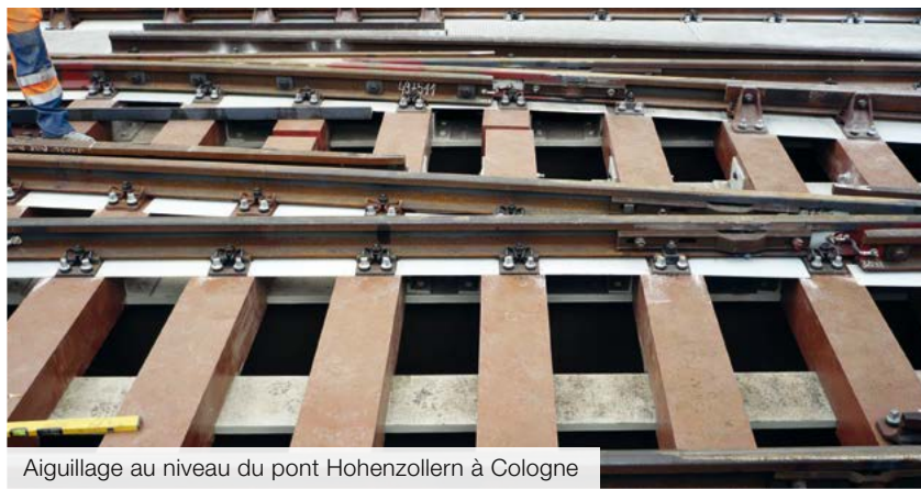
Logement spécial du bois artificiel FFU sur une structure porteuse en acier
