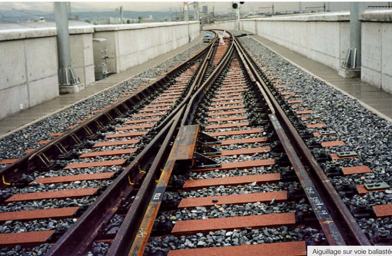
Aiguillage sur voie fixe, vissée dans la semelle en caoutchouc
