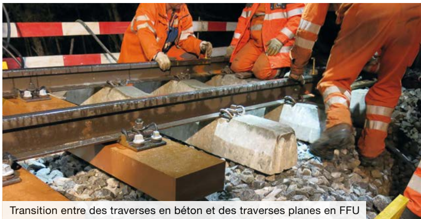
Bourrage d'une traverse plane avec bourreuse
